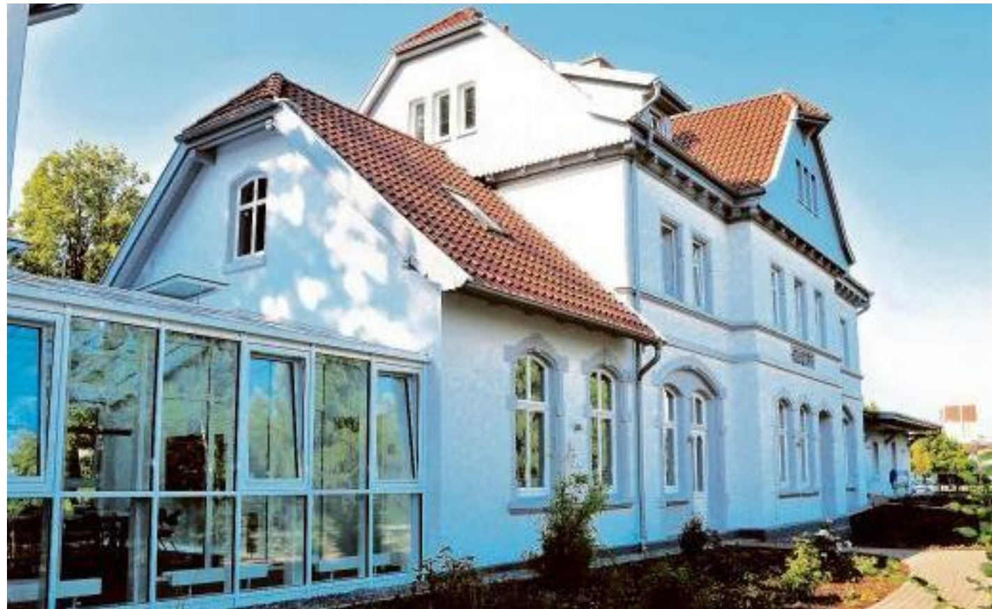
Das im Jahr 2012 umfangreich sanierte Bahnhofsgebäude in Holdorf: Von hier aus werden die deutschlandweit über 3000 Mitarbeiter der „ray facility management group“ gelenkt. Foto: Vollmer
